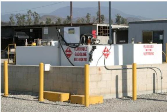
Proporcione estructuras de contención secundaria para los tanques de combustible.
