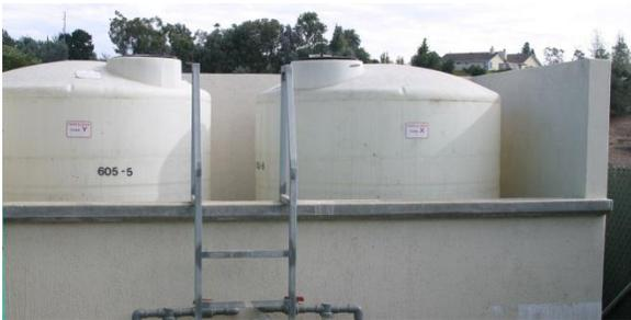
Almacene los pesticidas y fertilizantes sobre una superficie impermeable con estructuras de contención secundaria.
