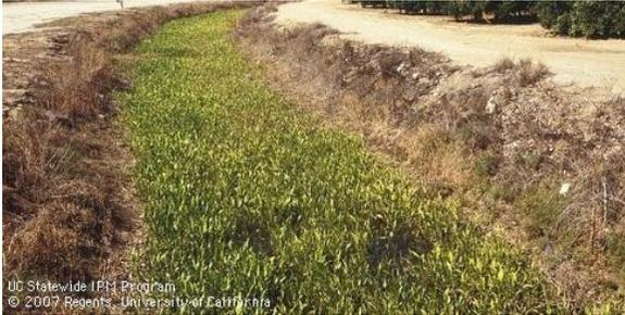
Los canales de drenaje con vegetación, capturan y reducen el escurrimiento y el sedimento.
