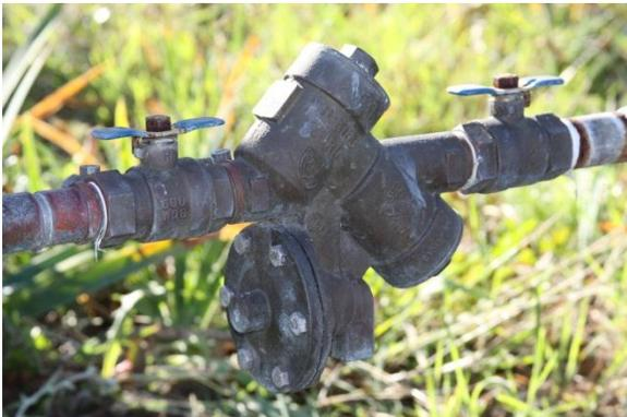
Los dispositivos de prevención de retroflujo evitan la contaminación de las fuentes de agua cuando se inyectan fertilizantes o pesticidas en el agua de riego.
